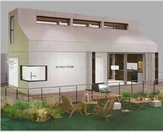
Das LG Smart Cottage wurde in Kooperation mit der koreanischen GS Engineering & Construction Corp. entwickelt.
