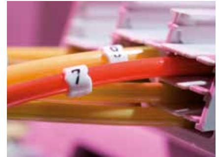
Auch in diesem Jahr investiert die Telekom wieder massiv in der Glasfaser-Ausbau.
