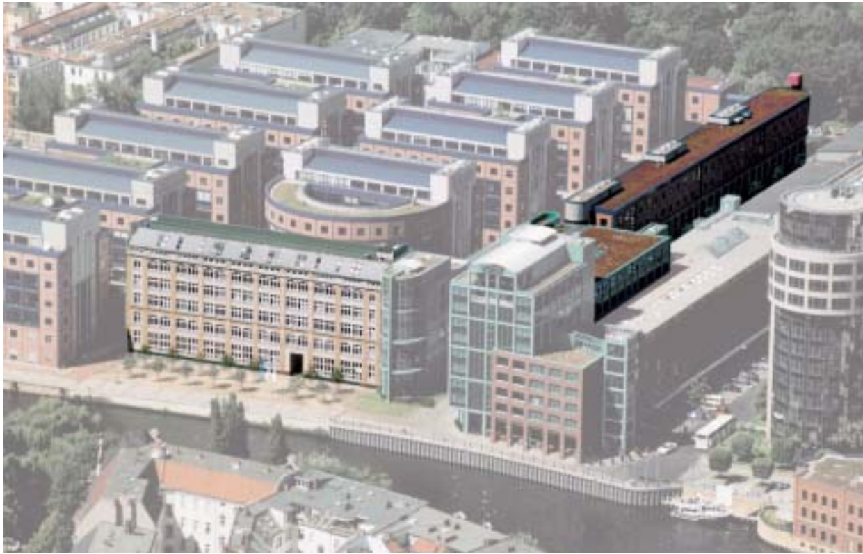
Neben dem bereits zuvor existierenden Firmengebäude direkt an der Spree kann AVM zukünftig auch ein in unmittelbarer Nähe liegendes Gebäude mit rund 3.500 Quadratmetern Fläche nutzen.
